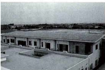
太陽光パネルは本館棟と調理棟の屋根に設置されています。
