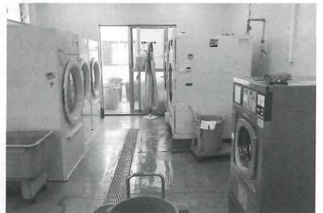
左側3台がガス式乾燥機、右奥側2台が洗濯脱水機、右側手前が汚物除去機になります。
